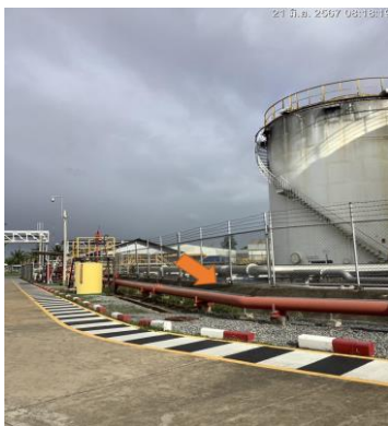
ภาพที่ 2-5 คันคอนกรีตสูง 1.00 เมตร ล้อมรอบลานถังเก็บน้ำมัน
